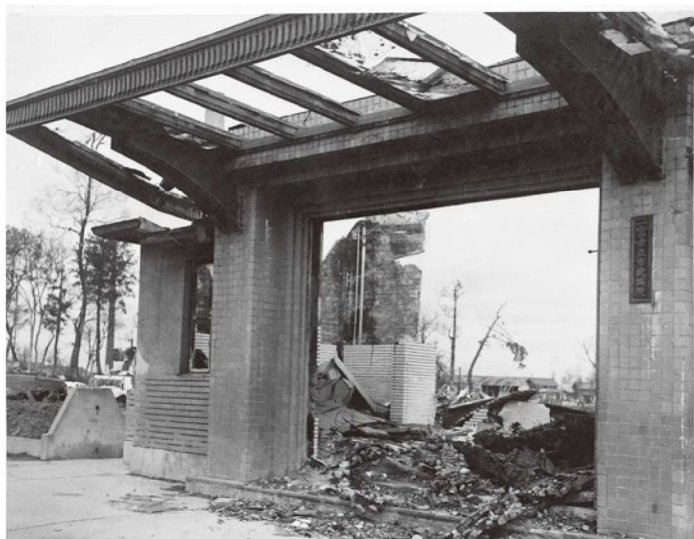
▲玄関部分のみを残し、建物の大部分が焼失(1945年)
